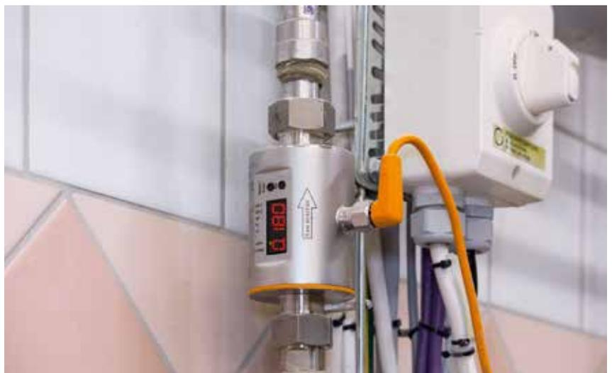
面团生产的水量通过电磁感应式流量计精确检测。
