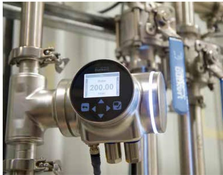
的优势和实用性——可靠和可重复地监控 CIP 和 SIP 过程，使其能够在很短的时间内对过程进行优化；精确测量流量和温度，简单的管式结构不仅提升了清洗和消毒效率、而且使整个系统的效率都大大提高。◻
