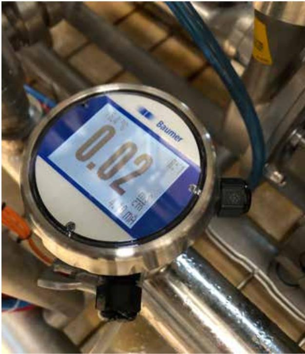
堡盟根据EHEDG标准开发了市面上最卫生的过程连接（参见《乳品加工业用传感器——行业指南》封面）。堡盟卫生型连接（BHC）完美融合了Tri-Clamp卡箍连接的简易性和齐平安装的卫生性，可大大提高清洗效率，降低污染风险。
